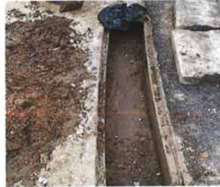
ภาพที่ 2-13 การขุดลอกตะกอนภายในรางระบายน้ำของโครงการ
