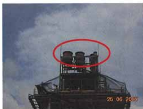
ภาพที่ 2-3 Silencer บริเวณวาล์วนิรภัยโรงไฟฟ้า (Safety Valve)
